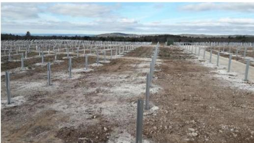
L'utilisation de liant hydraulique peut s'avérer nécessaire ponctuellement selon le type de sol rencontré. Il convient généralement de creuser des trous sur une profondeur de 0,5 à 1 m pour un diamètre de 30 cm, puis d'ancrer les pieux à l'aide de béton (non visible, puisqu'il ne dépasserait pas du sol) ; cette technique ne sera envisagée sur le site qu'en dernier recours.
