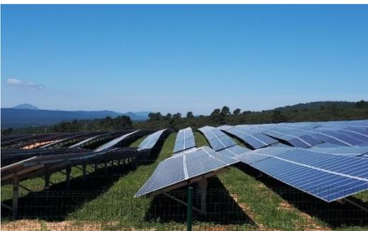
L'intégralité des câbles électriques entre les postes et les panneaux seront enfouis. Le terrain ne sera pas terrassé. Une fois terminé le parc photovoltaïque ne laissera apparaître que la clôture, les châssis, les panneaux et les locaux techniques.
